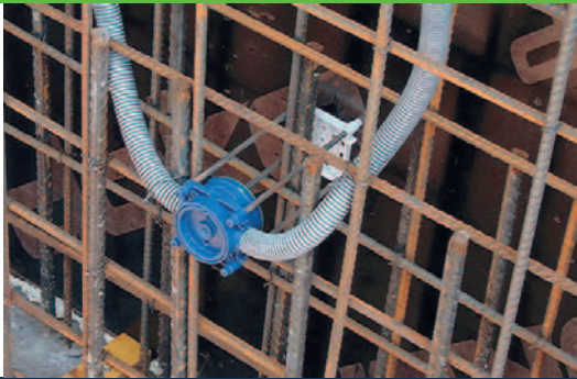
◀ Vertikale Installation bei Ortbetonbauweise
